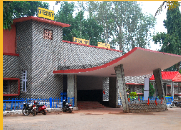
जगदलपुर स्टेशन के सर्कुलेटिंग एरिया का उन्नयन
